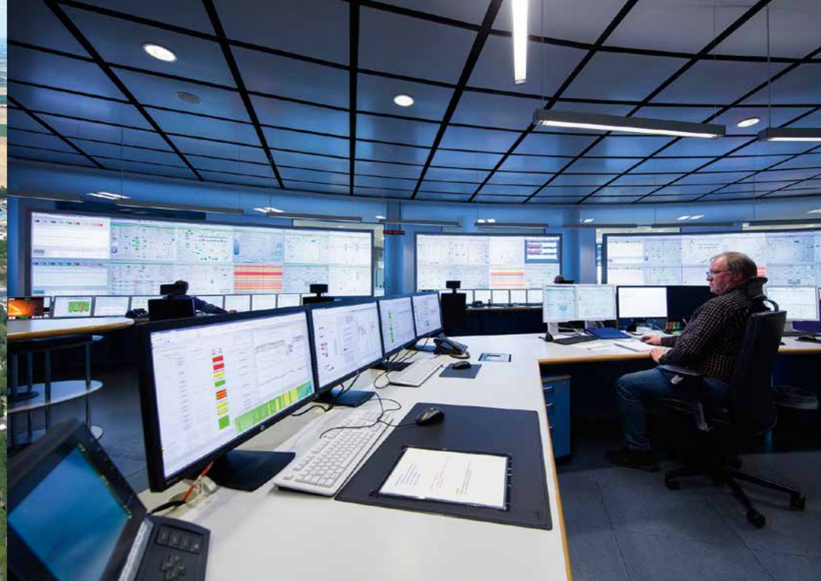
Leitstand des BoA-Kraftwerks in Neurath: Nur wenige Fachleute sind nötig, um den vollautomatischen Betrieb der Anlage zu überwachen. Durch die zunehmende Flexibilität im Energiemarkt und in der Energietechnik wächst die Anfälligkeit des Systems für Störungen.
