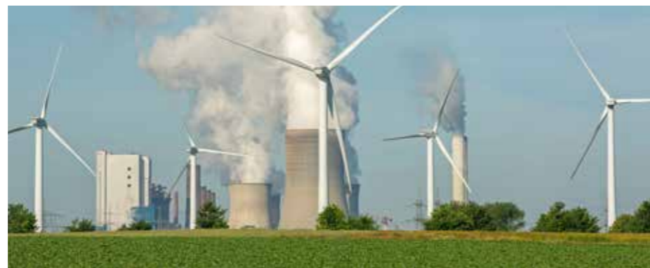
Windenergieanlagen vor dem Kraftwerk Niederaußem.
