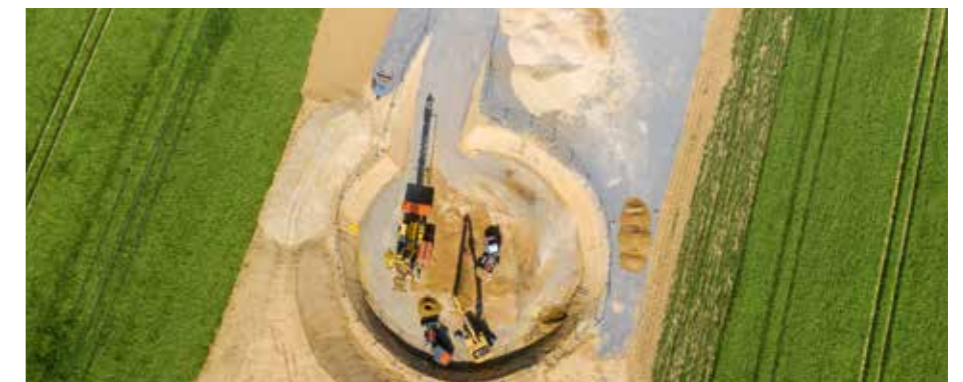
Baustelle bei Jüchen: Ist die Windenergieanlage errichtet, wird der Bauplatz rekultiviert.
