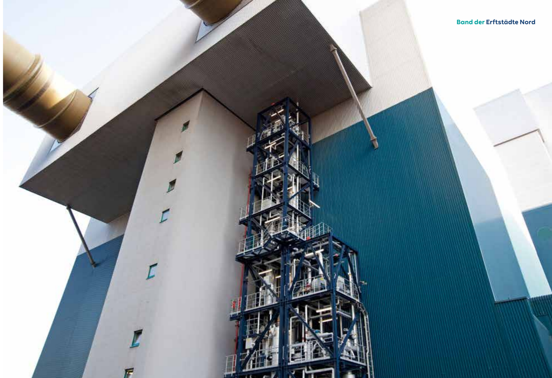
Chemiefabrik im Kleinen: Die Pilotanlage zur CO 2 -Rauchgaswäsche wurde im Schatten der Rauchgasentschwefelungsanlage des Block K errichtet.
