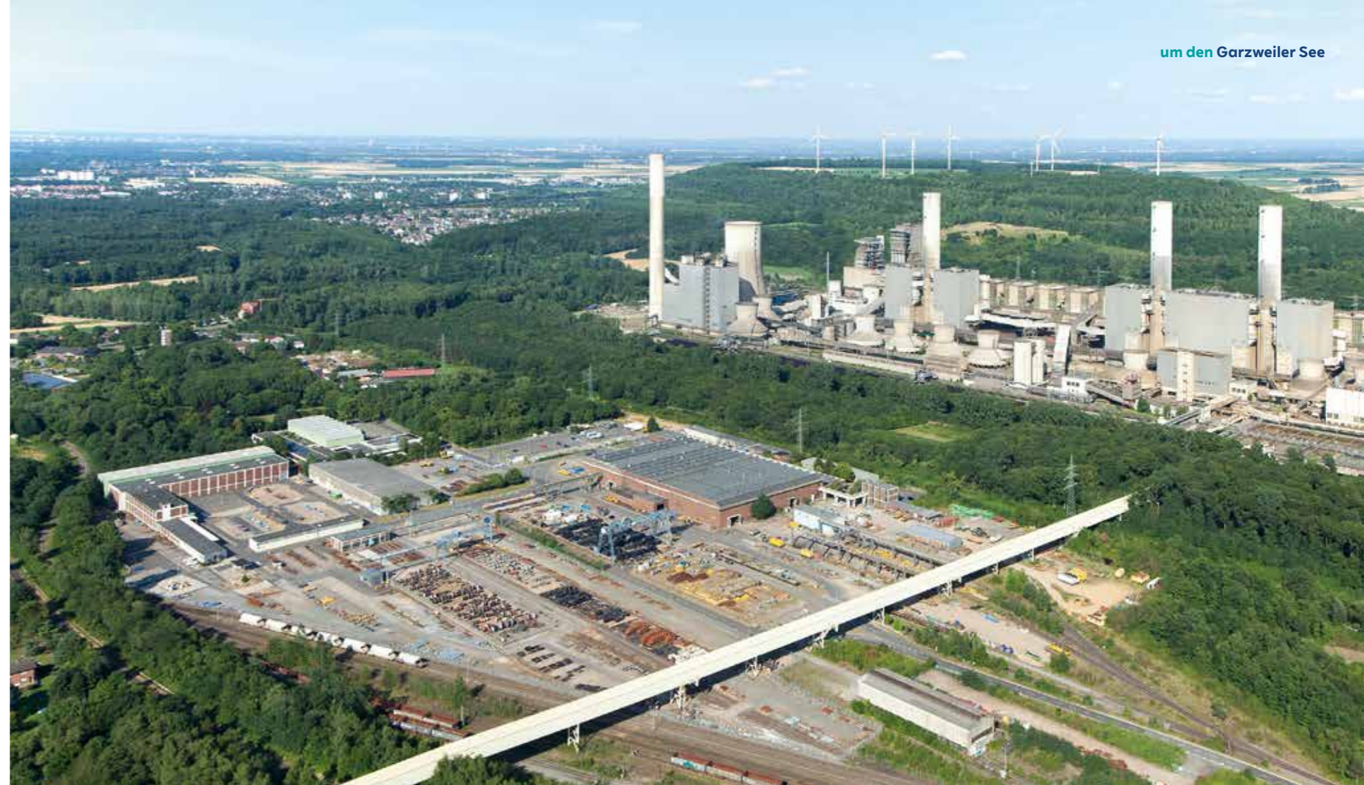
Die beiden letzten Blöcke P und Q des Kraftwerks Frimmersdorf, im Volksmund „Paula“ und „Quelle“ genannt, werden 2021 endgültig stillgelegt.
