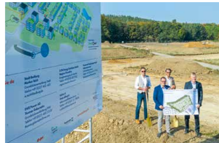
Im Oktober 2020 begann die Erschließung des Baugebiets – der ambitionierte Plan wird umgesetzt.
