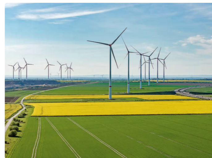
Windpark Jüchen A44n: Grünstrom für mehr als 26.000 Haushalte
